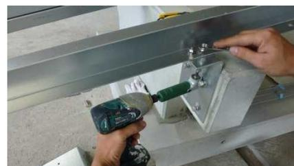
梁材の前側先端に、モジュール受材を M8x20 ボルトにバネ座金と平座金を組み付けて、M8 ナットで締結します。梁材の後ろ側端部にもボルト穴がありますが、ここには何も取り付けません。
