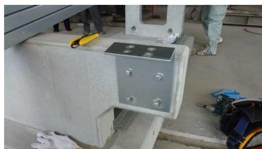
受金具に梁材を載せ、M8x20 ボルトにバネ座金と平座金を組み付けて M8 ナットで仮締結します。（梁材の刃が外向きとなり、モジュール取付穴が上側に位置するように配置します）
