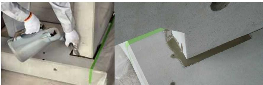
モルタルの充填は、1箇所あたり2回に分けて行います。1回目に充填されたモルタル内のエアが抜けるのを待って、2回目を充填します。
