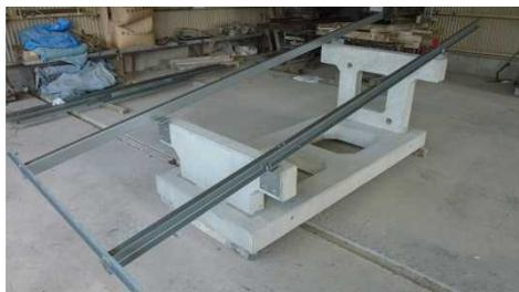
桁の上端のモジュールゲージ寸法を確認します。
